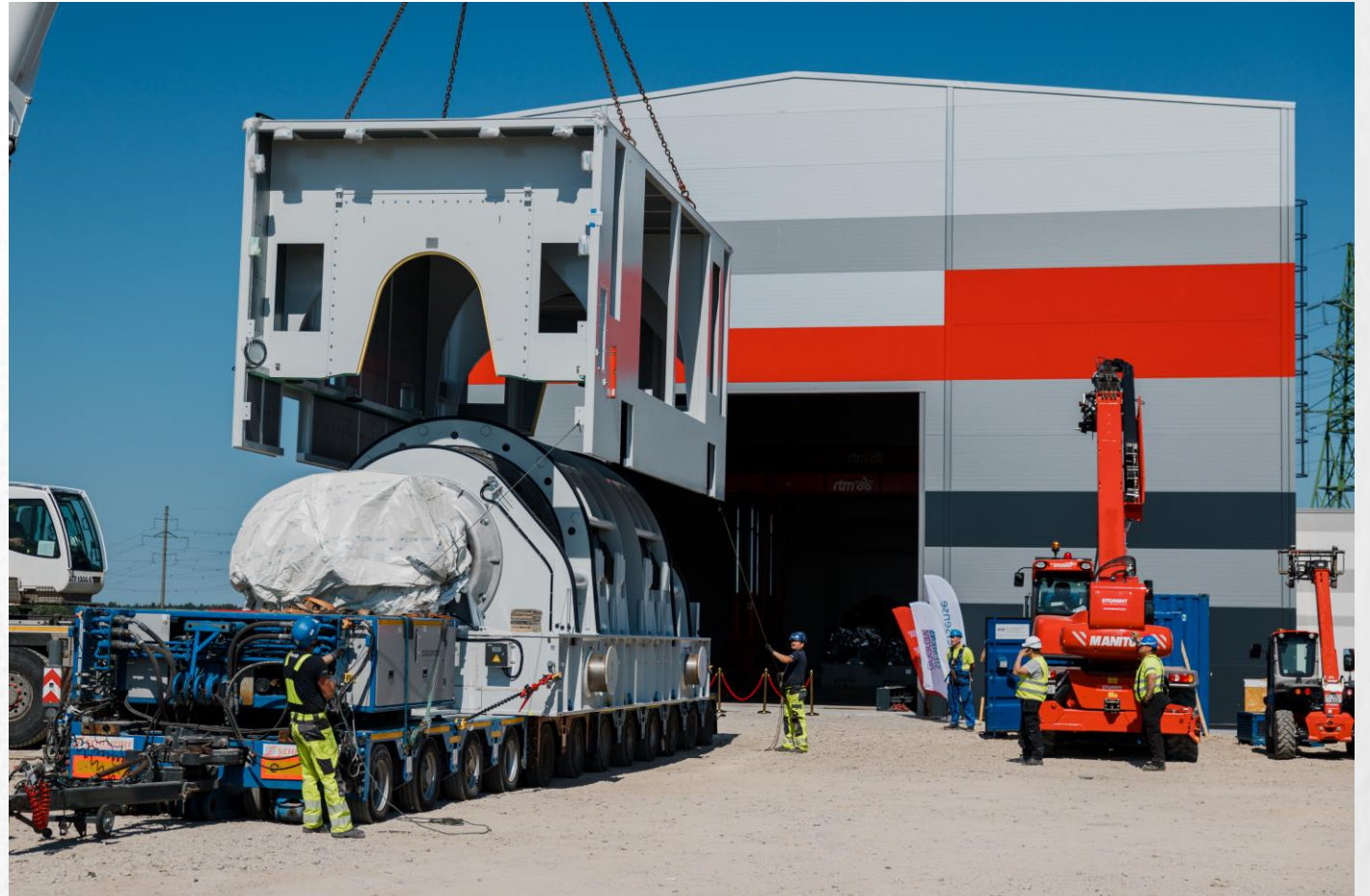
Sinhronā kompensatora transportēšana uz a/st. Grobiņa, Maijs 2024
